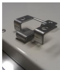
Detail eingehängte Deckenhalter
