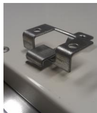
Detail eingehängte Deckenhalter
